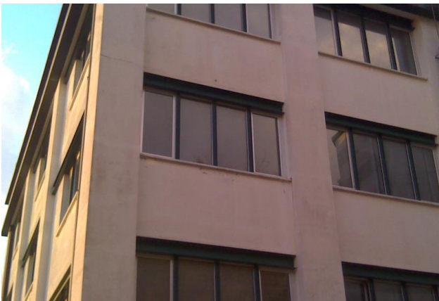
Figura 1: Prospetto retrostante lato est
